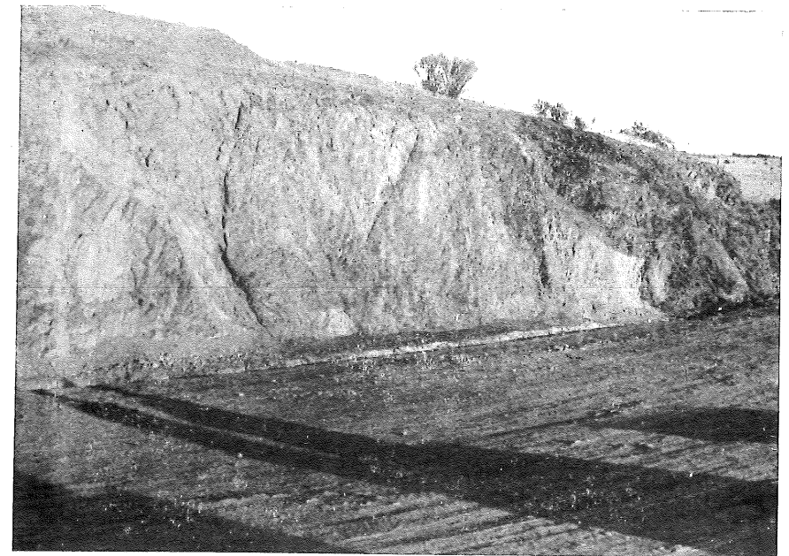
Fig. 2.—Corte en trinchera en la carretera de Alburquerque, en las inmediaciones del Km. 40. Se aprecia una fractura o falla en los materiales pizarrosos del Siluriano, que están intensamente milonitizados y estrujados contra una gran masa de cuarcitas igualmente milonitizadas. Vista hacia el SE., de detalle.
